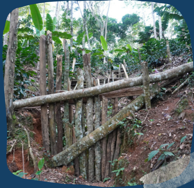
-Trinchos, Sistema de contención de suelo.
